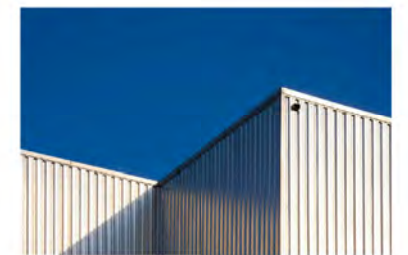
Despatch / pallet store: Composite cladding
